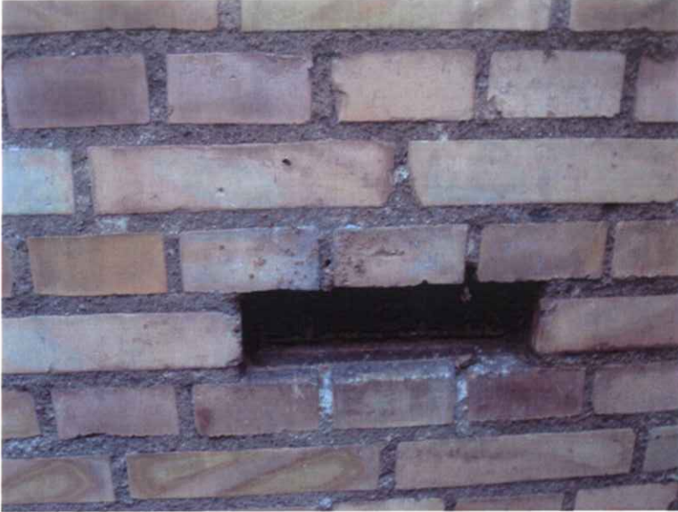
Billede 19 Gennemtæret facaderist
