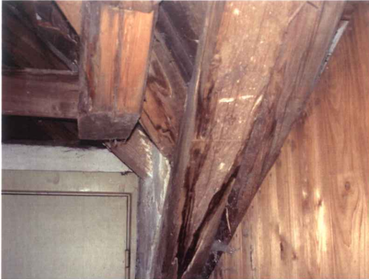
Billede 31 Opfugtet tømmer under skotrende
