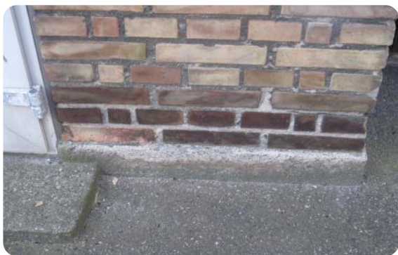
Udvasket fuge ved sokkel.
