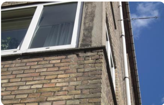
Sætningskade på hjørne af bygning forsætter op til de øvrige etager.
