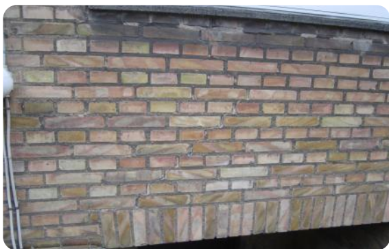
Sætningsskade samt udvasket fuge.
