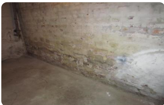
Eksempel muret kælderindervæg, der bærer præg af tidligere vandskade i kælder.
