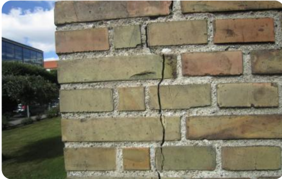
Sætningskade på hjørne af bygning, samme skade ses rundt om hjørne.
