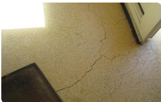
Revner i terrazzogulv.
