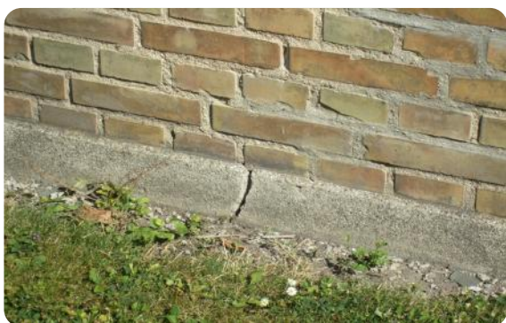
Fundament mod gade.
